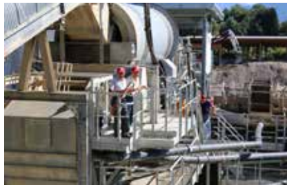
Produktion Gesteinskörner im Kieswerk
