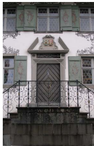
Sandsteinarbeit am Custorhaus (Doppelläufige Treppe und Portal mit Sprenggiebel)
