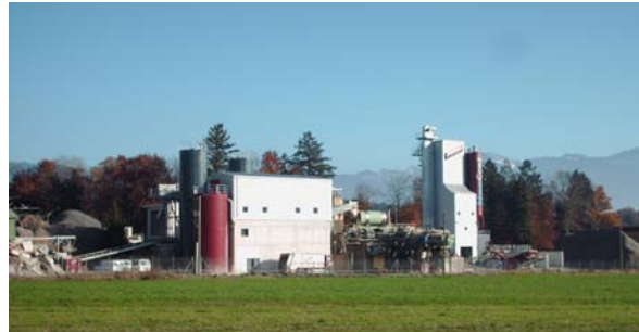
Abfallsortier- und -aufbereitungsanlage zu Recyclingbaustoffen und Verarbeitung von Rohkies zu Kies- und Betonprodukten in der ehemaligen Kiesgrube und Abfaldeponie Hinterwies
