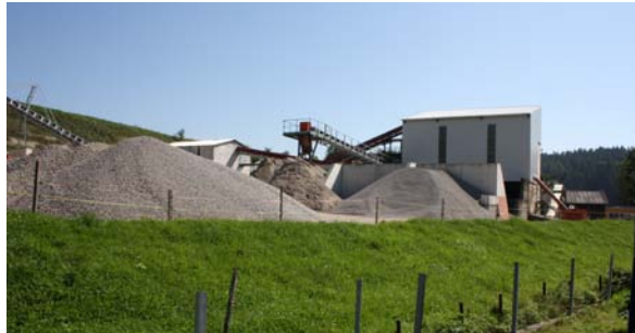
Aufbereitungsanlage ehem. Kiesgrube Mettlen
