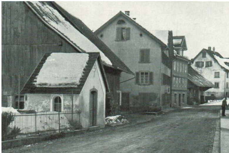
Naturstrasse durch das Dorf
