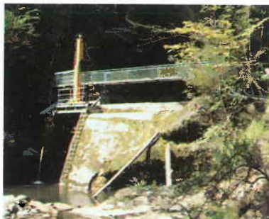
Gemauertes Stauwehr, erstellt 1867
