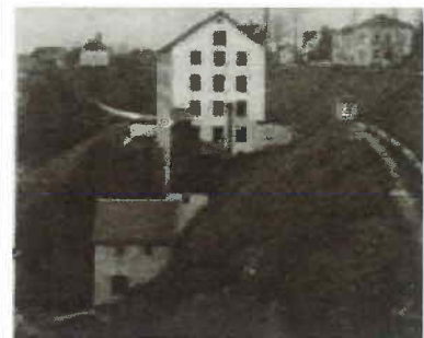
Fabrik Ostansicht mit Turbinenhaus
