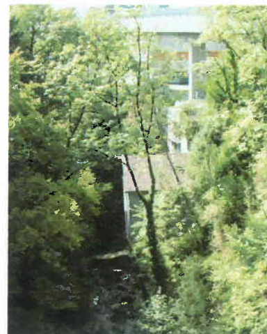
Verträumte Idylle unter dem Lehnviadukt: Das Turbinenhaus im Aatal
