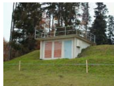
Reservoir Hinterbergen – erstellt 1960
