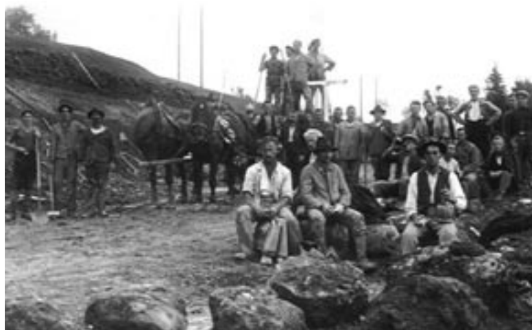
Stimmungsbild auf einer Strassenbaustelle von anno dazumal
