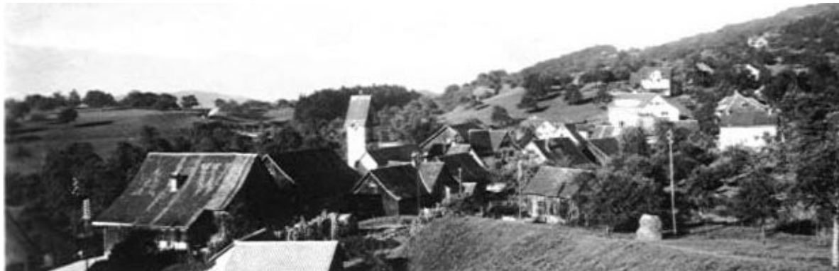
Bürg: Rechts der Verlauf der alten Verbindung von der Schwärzi nach Bürg. Das markante Doppelwohnhaus Wey links im Bild fiel zu Beginn der 70-er Jahre des letzten Jahrhunderts im Zuge der Korrektur der Ortsdurchfahrt Bürg leider der Spitzhacke zum Opfer.
