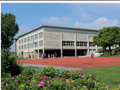
Gesamtsanierung Schulhaus Kirchacker
