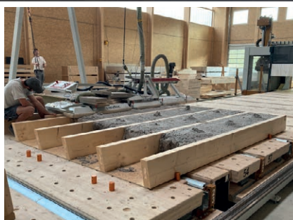
Dach für neue Sporthalle wird bald aufgerichtet
