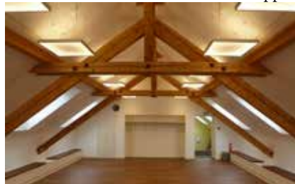
Neue Aula im Schulhaus St. Gallenkappel
