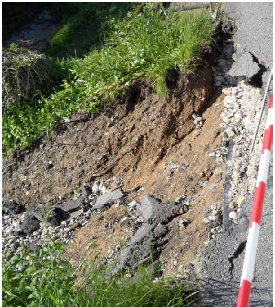
Hintergoldingerstrasse oberhalb Liegenschaft Wirth
