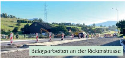
Nun musste im Zuge der laufenden Bauarbeiten auf einer Fläche von 1'100 m<sup>2</sup> ein kompletter Belags- und Fundationsersatz durchgeführt werden. Die Kosten dafür belaufen sich auf rund Fr. 151'000.-. Dabei handelt es sich um eine gebundene Ausgabe, welche der Rat ohne Kredit tätigen kann. Noch unklar ist, ob und inwiefern sich der Kanton trotz Verjährung an dieser Bereinigung finanziell beteiligen wird. Entsprechende Gespräche laufen.
