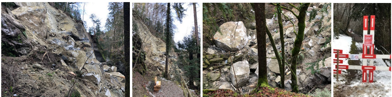
Bild 1-3: Erneuter Niedergang von ca. 8-14'000 Tonnen Felsmaterial Bild 4: Wanderweg war bereits gesperrt
