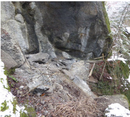
Felssturz auf dem Fussweg
